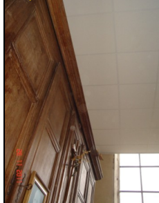
Plafond de la sacristie
